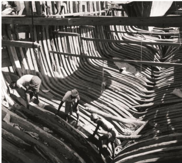
المعلا مركز صناعة السفن ١٩٥٠م تثبيت أضلاع أحد السفن الخشبية
